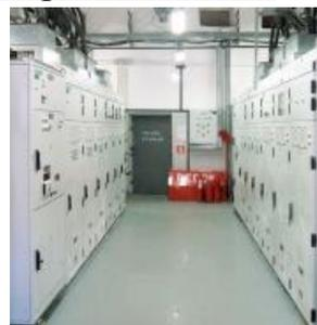
Устройства плавного пуска высоковольтных ЭД (пусковые устройства) – эффективное устройство, используемое для плавного пуска (остановки) электродвигателей, обеспечивающее ограничение величины пускового тока, а также позволяющий осуществить пуск ЭД и силовых питающих трансформаторов от источников ограниченной мощности.
